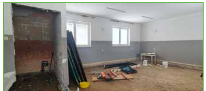
Świetlica w Kaczku w trakcie prac
